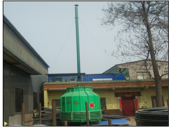
现有工程环保设施
