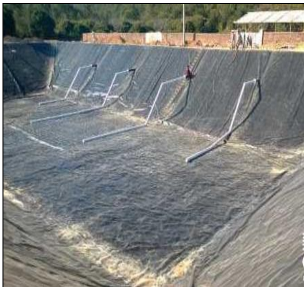
图 5-5 黑膜沼气池内部示意图
