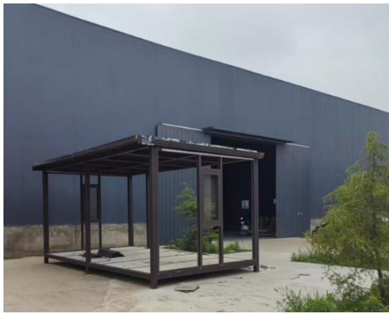
项目东侧的隔热板厂
