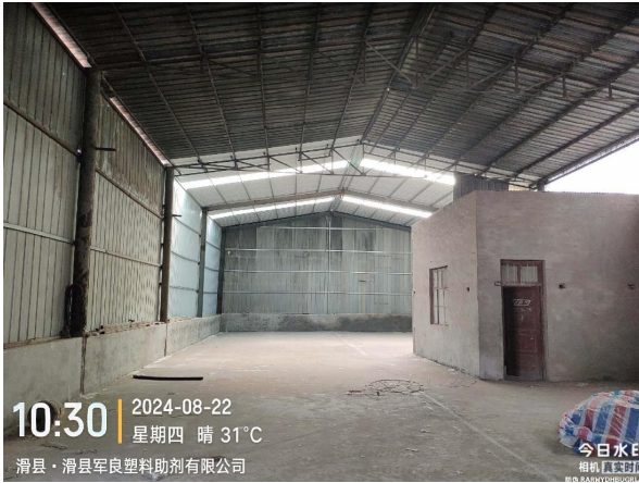
项目车间现状
