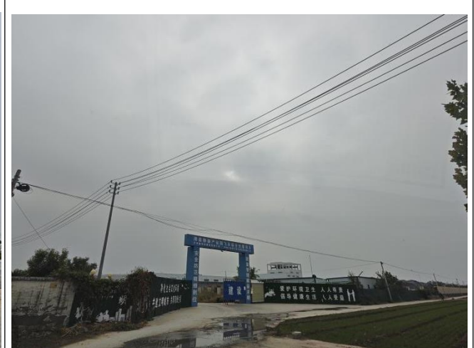
项目西侧飞灰综合处置项目
