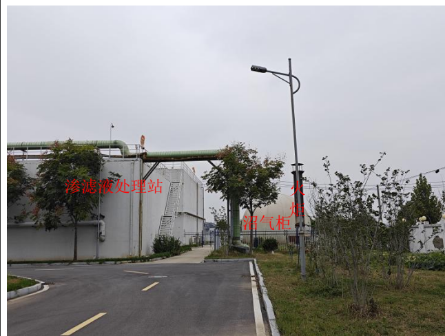
依托的沼气柜、渗滤液处理站、火炬
