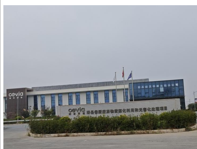
项目北侧餐厨垃圾处理项目
