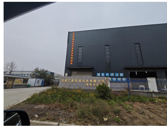
项目北侧兰恩环保炉渣综合利用项目
