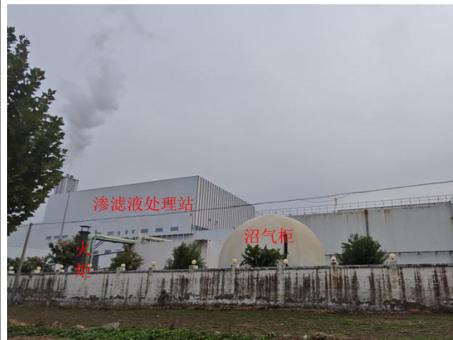
依托的沼气柜、渗滤液处理站、火炬（围墙外拍摄）
