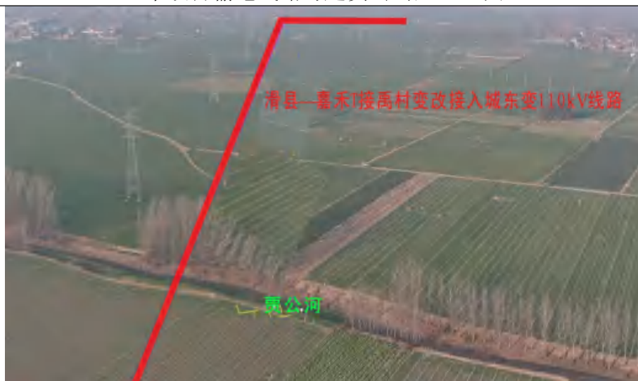
本项目输电线路跨越贾公河处现状照片
