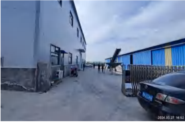
项目厂区现状
