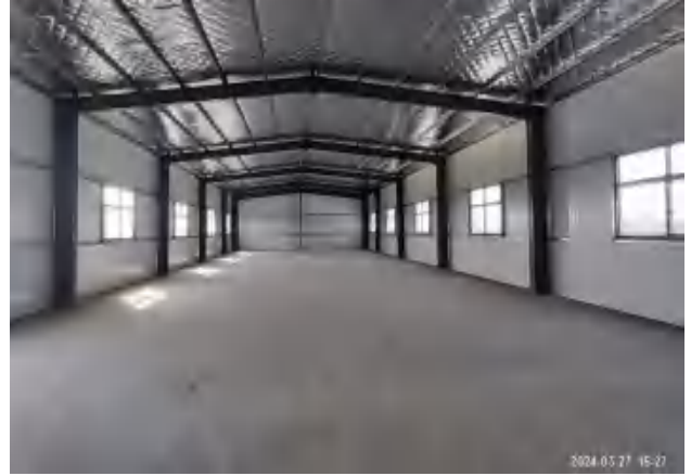
项目南侧厂房现状
