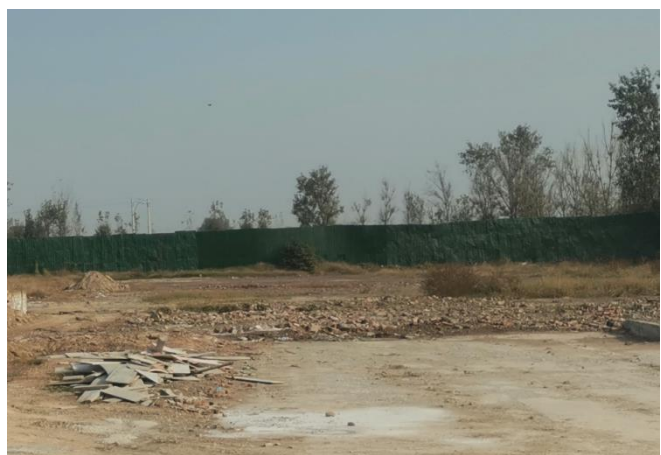
项目厂区北厂界
