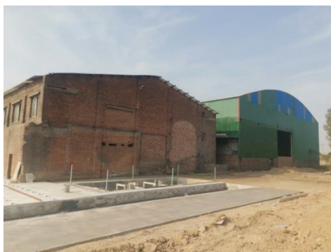
项目厂区现有厂房
