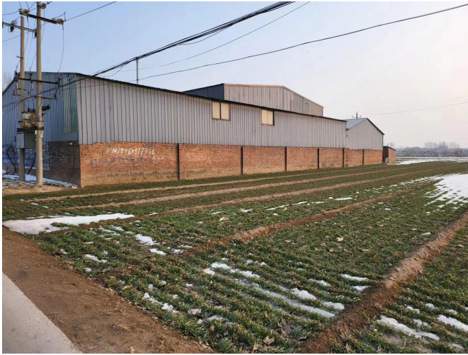
已建设的部分厂房
