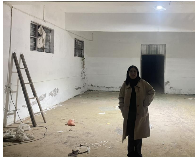
工程师踏勘现场照片
