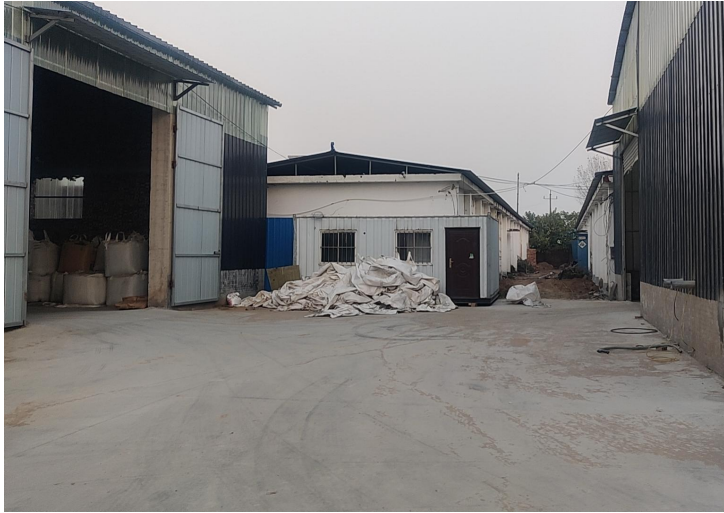
项目厂区现状
