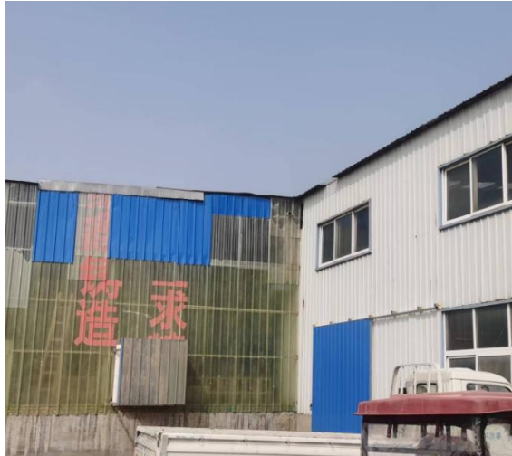
厂区现有厂房
