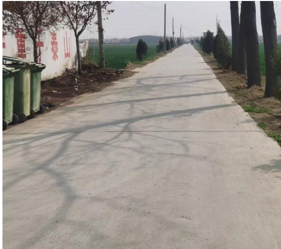
厂区南侧道路
