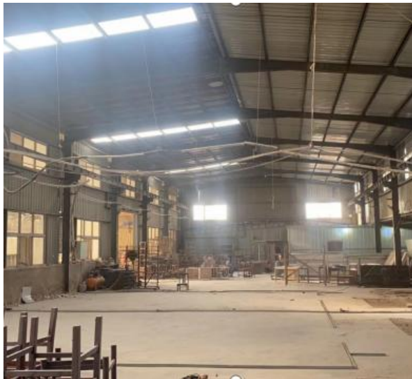
厂房内现状照片
