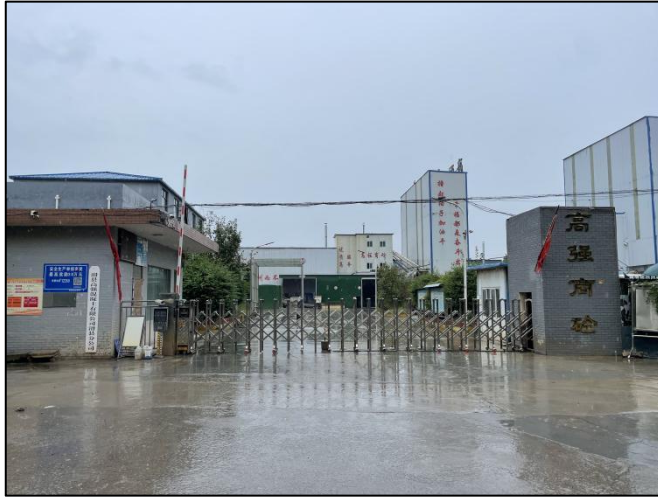
项目地块内西侧高强商砼
