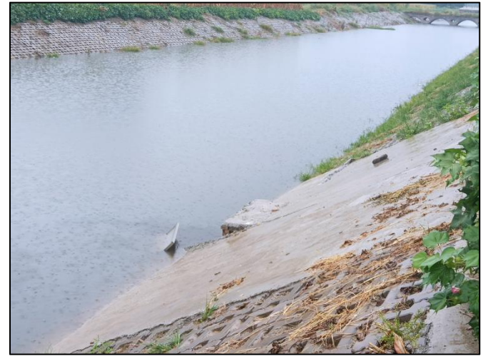
第二污水处理厂入河排污口
