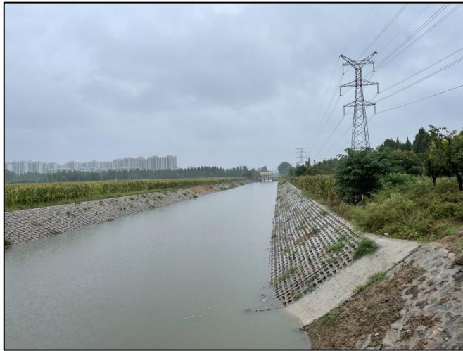
项目西侧城关河
