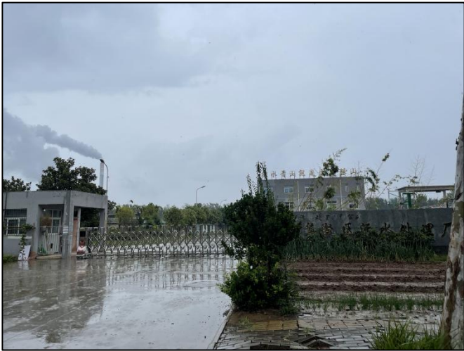
项目西南侧的第二污水处理厂
