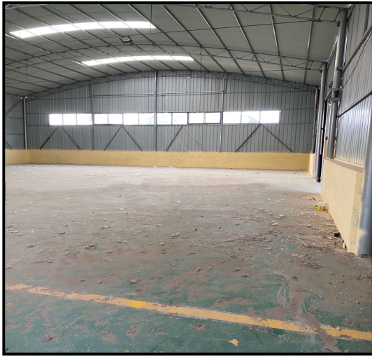
厂区生产车间现状照片
